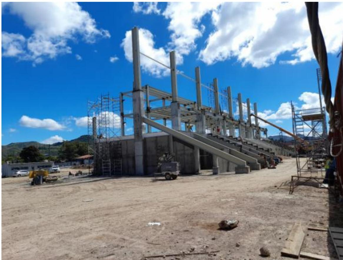
Fotografía N° 1 Vista frontal: del 12 Nov al 25, el Contratista avanzó en la instalación de elementos metálicos para peldaños, elemento de arriostre entre columnas metálicas, soldaduras de unión entre elementos estructurales principales, estructuras y laminas metálicas para entre piso.
