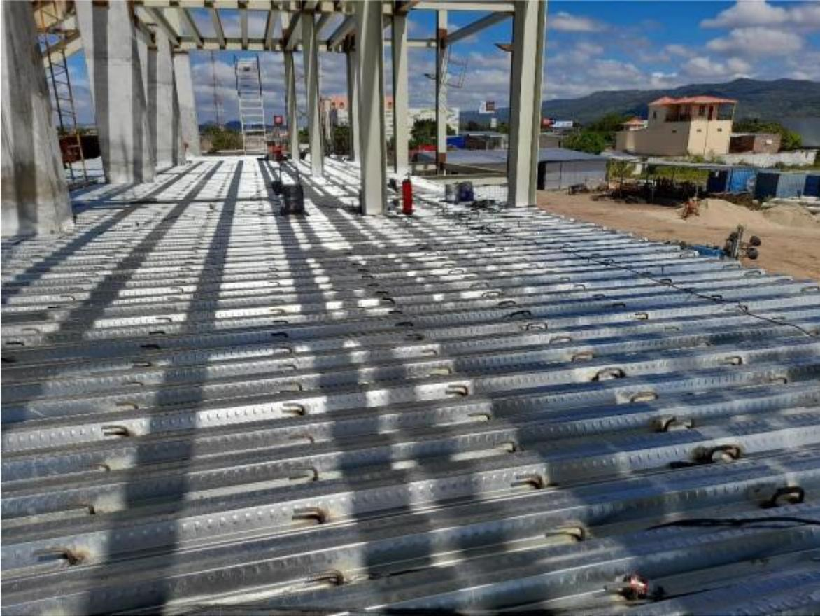
Fotografía #3, En primer nivel el Contratista ya instaló las láminas metálicas y pines de  $\frac{3}{4}$ " para adherencia de concreto que conformará el entpiso.
